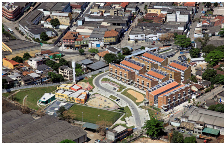
FIGURA 1 Núcleo habitacional e de serviços do Complexo do Alemão
