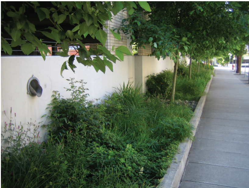
Figura 6: Canteiro pluvial ao lado da garagem do Liberty Center em Portland, Oregon Crédito: Nathaniel S. Cormier
