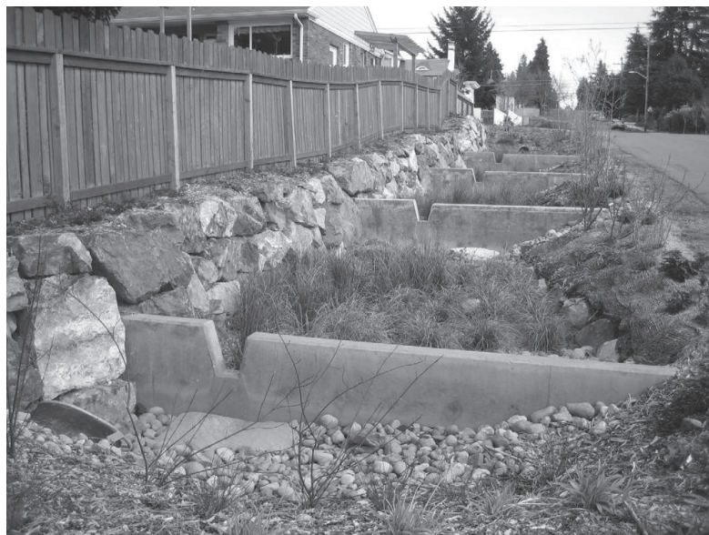
Figura 19: Biovaletas logo após sua implantação em Broadview. Hoje, essas estruturas se encontram praticamente escondidas pela vegetação
