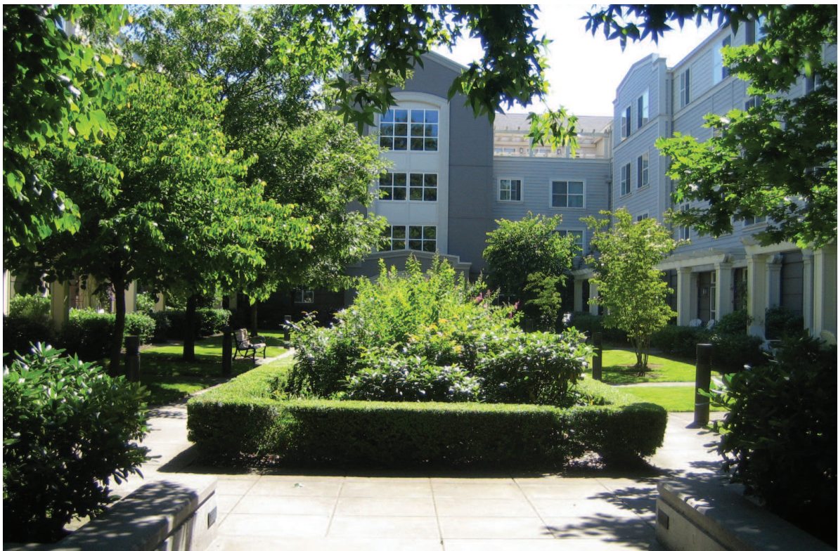
Figura 4: Jardim de chuva do conjunto de apartamentos Buckman Heights em Portland, Oregon
