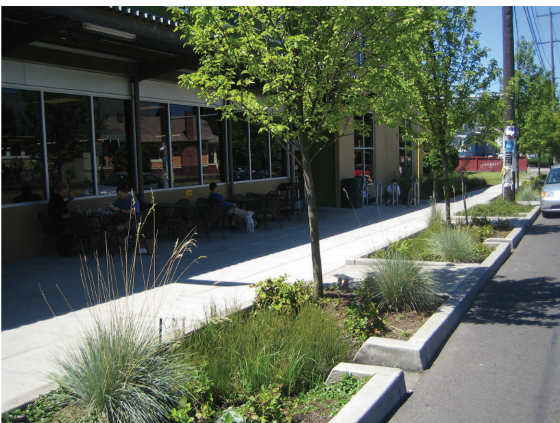
Figura 7: Os canteiros pluviais junto do New Seasons Market, em Portland, Oregon Crédito: Nathaniel S. Cormier
