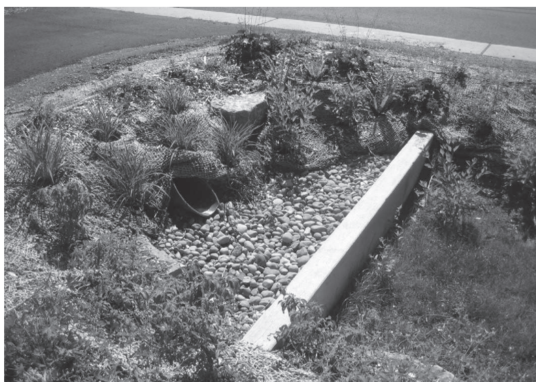
Figura 20: Vista de uma bacia de sedimentação na grade verde de pinehurst, Seattle, Washington
