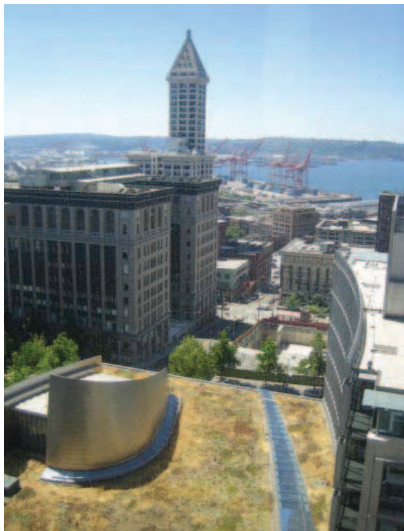
Figura 17: Uma vista da cobertura da nova prefeitura de Seattle City Hall, Washington
