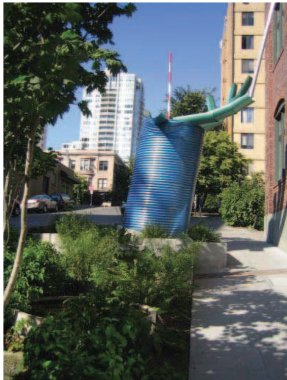
Figura 18: Uma visão da cisterna da Vine Street em Seattle, Washington
