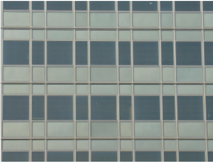
Pormenor da fachada contínua depois da intervenção Crédito: Simona Salvo
