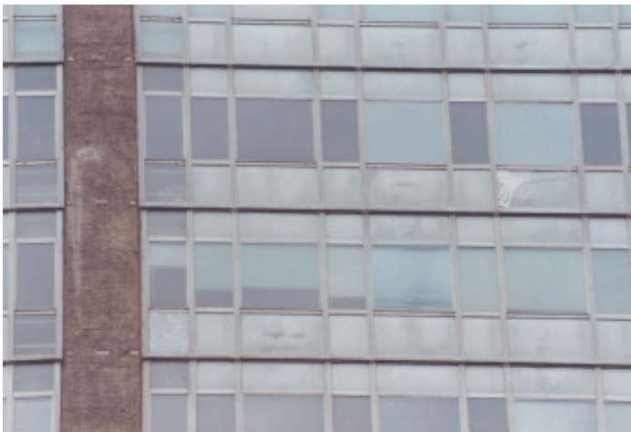
Pormenor da mesma fachada, antes da restauração Crédito: Simona Salvo
