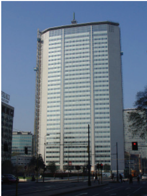
Fachada do edifício voltada para a praça Duque de Aosta após a restauração Crédito: Simona Salvo
