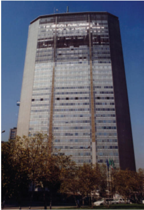
Danos causados pelo acidente aéreo de abril de 2002 Crédito: Simona Salvo
