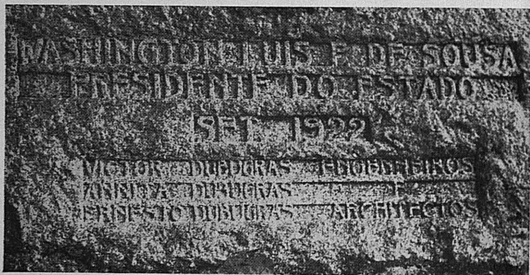
1 — Placa de granito existente no Pouso de Paranapiacaba com a inscrição:
