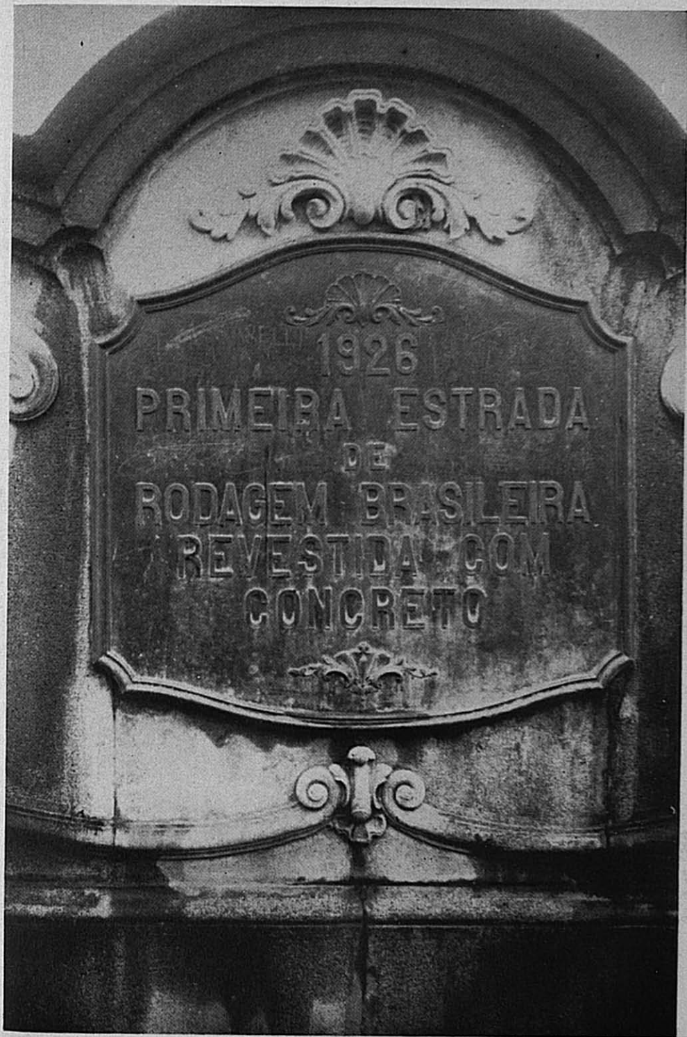
2 — Placa afixada ao pontilhão da raiz da serra.
