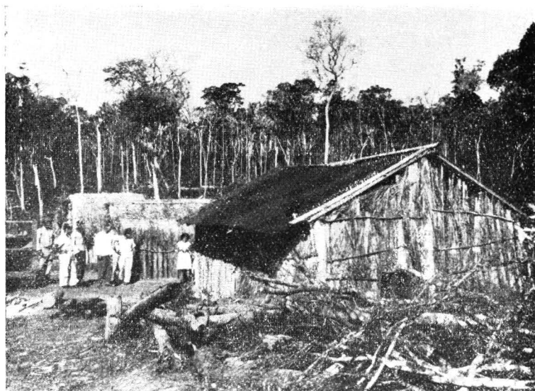
Fig. 7 — Derrubadas e início de formação de Fazendas. Notar os tipos das casas e a proximidade da mata virgem. Fazenda Santa Maria do Aguapeí, E. de São Paulo (VII-1952).
