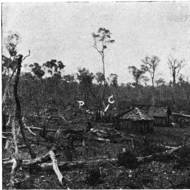
Fig. 34 — Casa do Sr. Severino Telles (Fazenda São Sebastião). Fotografia tirada na mesma ocasião em que foi obtida a da Fig. 32. O chiqueiro está assinalado pela letra C, e o poleiro, a êle adjacente, pela letra P.
