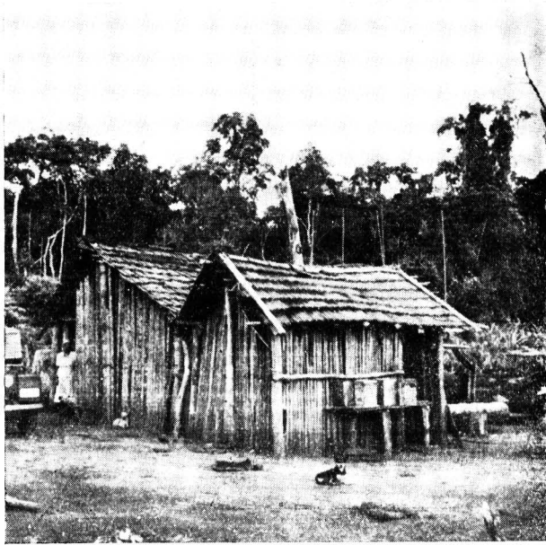
Fig. 46 — Casa de pau-a-pique onde foram capturados P. intermedius , P. whitmani e P. pessoai . Região de Martilândia (II-1952), Estado de São Paulo.
