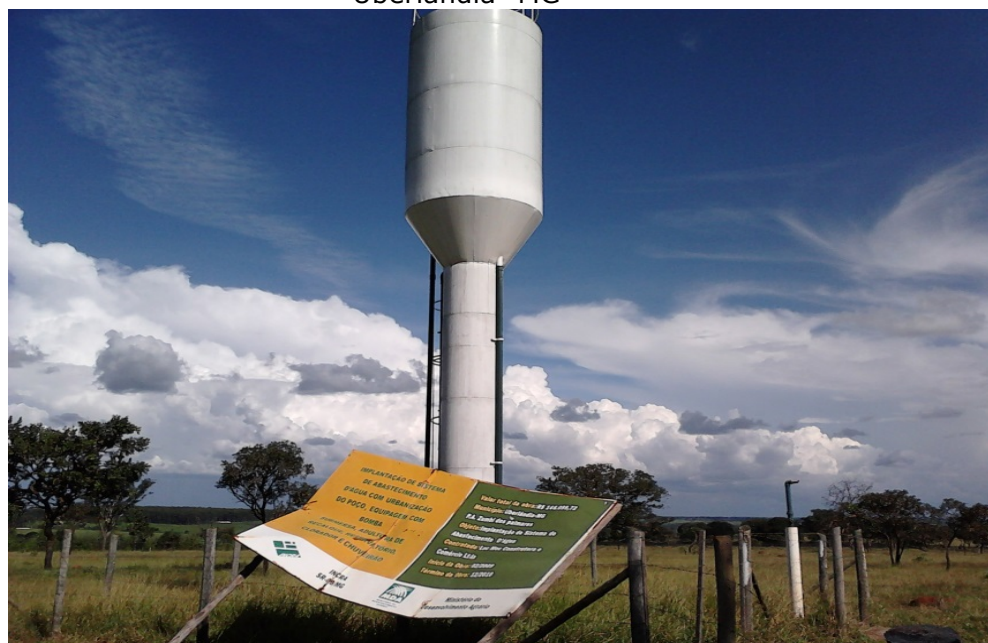
Figura 2: Caixa d'água abandonada no PA Zumbi dos Palmares, Uberlândia -MG
