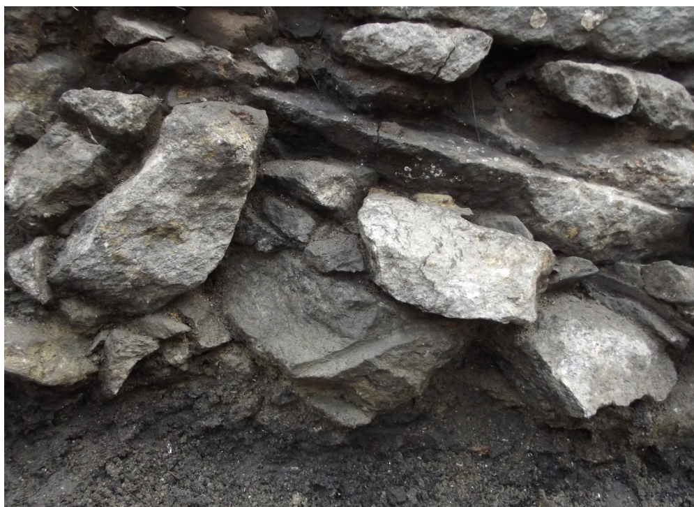
Figura 95 – Marca de dinamite em uma das pedras na base da estrutura, atestando que se trata de reparo posterior à década de 1870.
