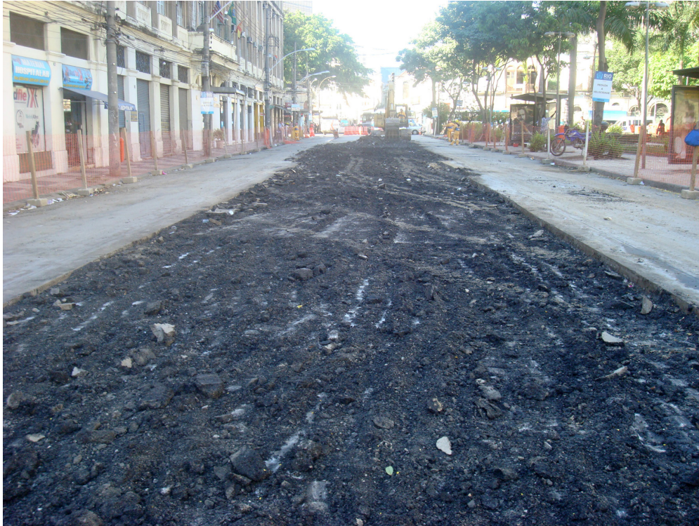
Figura 14 – Trincheira demarcada para escavação mecânica ao longo da pista esquerda da avenida Barão de Tefé, no sentido da rua Sacadura Cabral, para implantação da galeria de águas pluviais.
