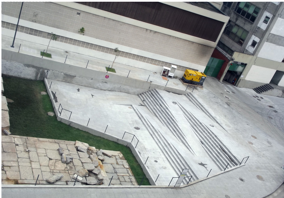
Figura 117 – Escadas, rampas de acesso e ponto de observação para o público
