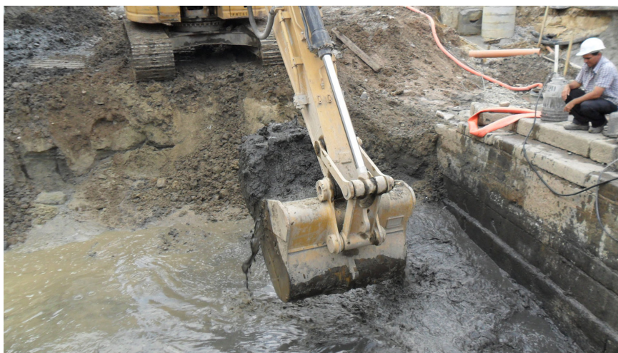
Figura 76 – Escavação mecânica dos níveis alagados da área em frente ao cais.
