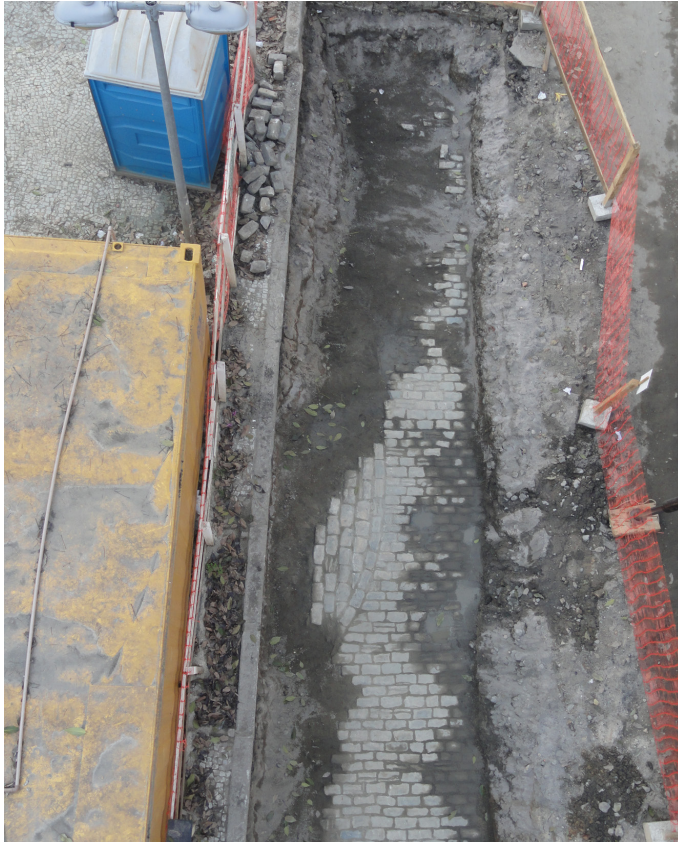
Figura 62 – Segmento preservado do calçamento do Cais da Imperatriz na trincheira paralela da Frente I, na altura entre os Trechos 7 e 14.
