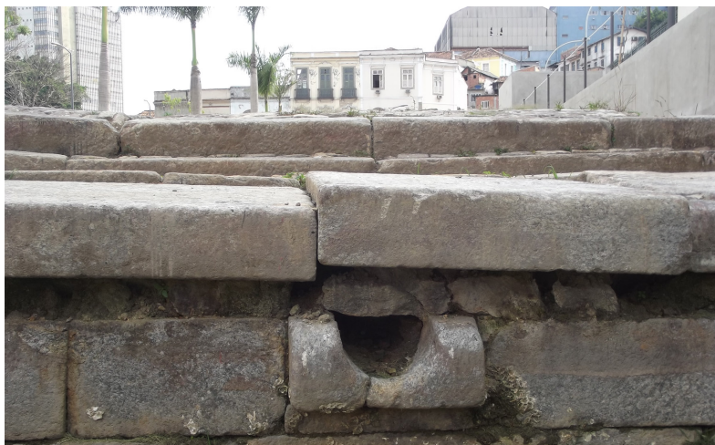
Figura 92 – Detalhe da bica em pedra lavrada, composta por duas pedras unidas. Note-se o mal sucedido preenchimento com pedras por baixo de uma das lajotas da plataforma, tentando mantê-la no nível original.
