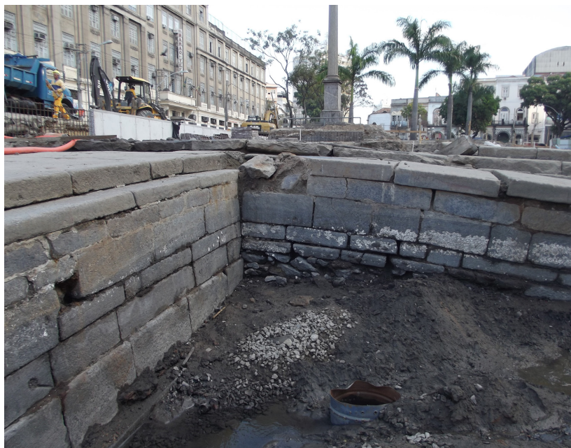
Figura 89 – Junção da parede ciclópica da rampa do cais com a parede à sua direita: ambas apresentam o mesmo sistema construtivo, atestando que a estrutura foi erguida de uma única vez.
