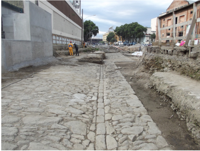
Figura 52 – A exposição do calçamento do Cais do Valongo na Frente 4, direção sul, e a canaleta de escoamento de águas pluviais. À direita vê-se a cuidadoso arremate do calçamento no limite com o piso de terra. À esquerda, o edifício do Hospital dos Servidores do Estado. À direita, o edifício das Docas D. Pedro II.
