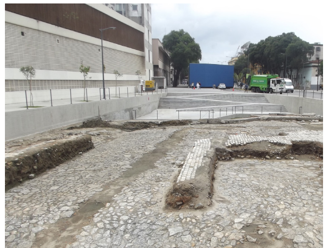
Figura 55 – Em nível mais elevado, as “ilhas” remanescentes do Cais da Imperatriz, muito danificadas pela implantação de diversas redes subterrâneas. Ao centro, vê-se uma das várias cicatrizes deixadas no calçamento do Cais do Valongo pela passagem de uma tubulação mais profunda.
