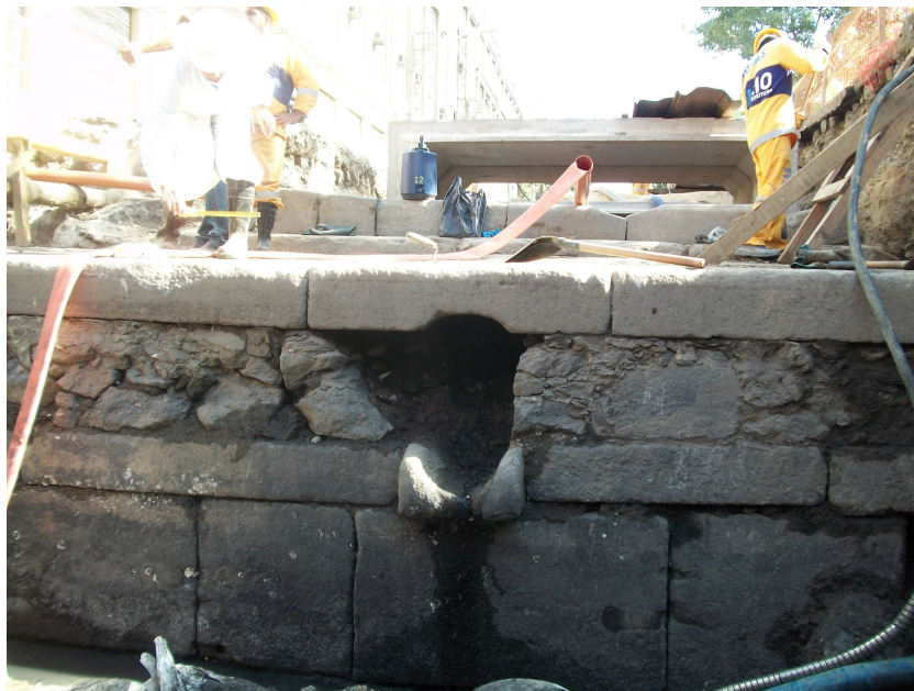
Figura 106 – Bica terminal do sistema de drenagem de águas pluviais da City Improvements.
