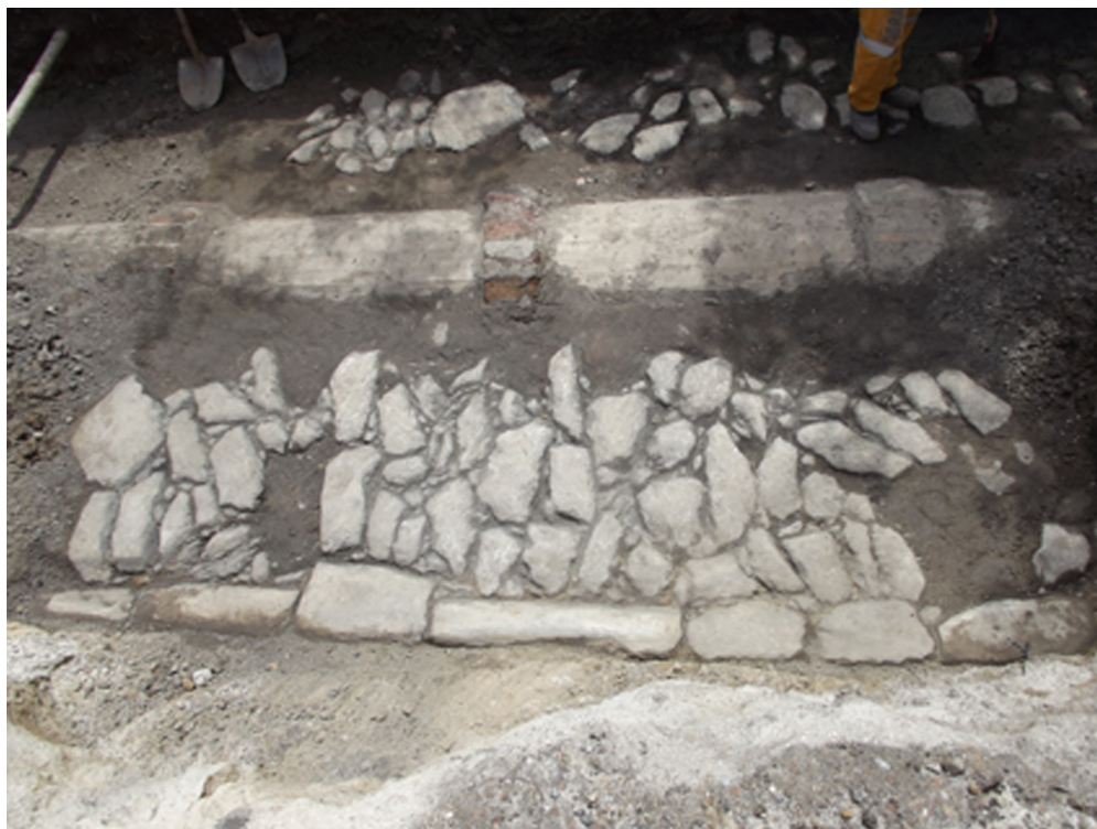
Figura 72 – A manilha que danificou o calçamento do Cais do Valongo no segmento correspondente ao limite entre os Trechos 10 e 11, e o arremate que o delimita, compondo uma borda.
