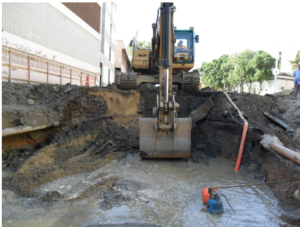
Figura 74 – Escavação mecânica da área em frente ao cais, na Frente 2, Trechos 1, 2, 3. Após a retirada das camadas de aterro, foram escavados mecanicamente os níveis arqueológicos, em parte inundados.
