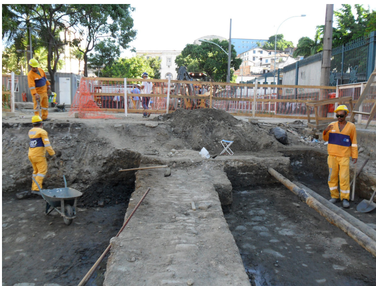
Figura 24 – Transformação das trincheiras em escavação em área ampla. Ao centro, segmento preservado do calçamento do Cais da Imperatriz.
