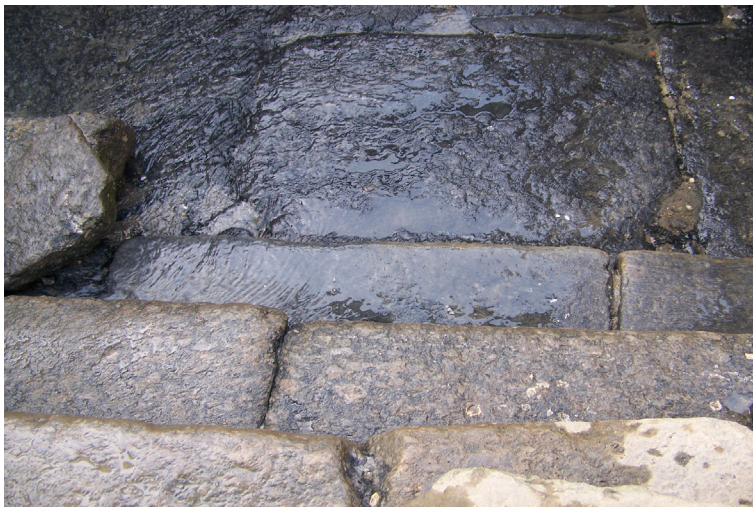
Figura 29 – Sequência de três degraus abaixo das lajotas de pedra do Cais da Imperatriz, em direção ao mar.
