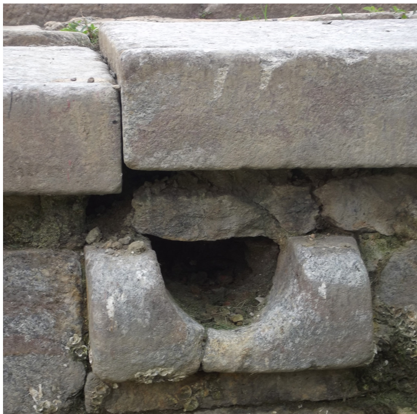
Figura 107 – Bica instalada no lado oposto, a 0,50 m de profundidade da superfície do cais, na Frente 2, para guardar simetria com a anterior.
