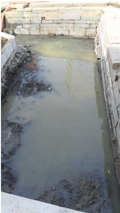
Figura 90 – Vista da área em frente ao cais, escavada até o nível alagado.
