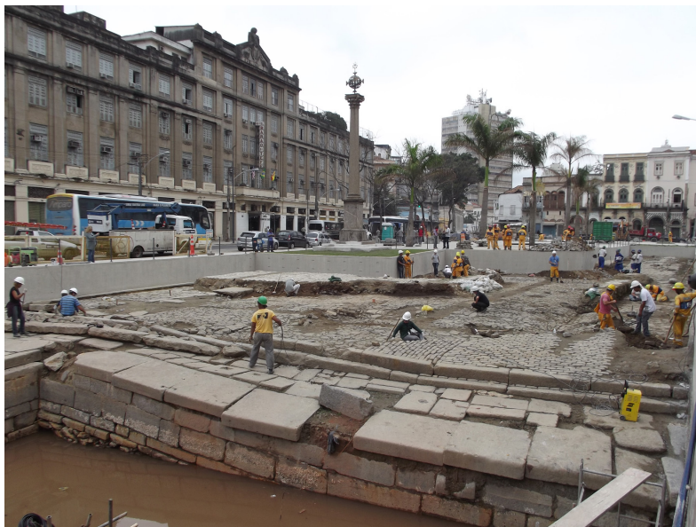
Figura 91 – Localização da bica na parede à direita da rampa do cais, desaguando no mar as águas provenientes de enxurradas da Ladeira do Livramento.
