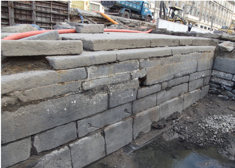
Figura 84 – O paredão lateral da rampa do Cais da Imperatriz, com o nível inferior alagado e parcialmente encoberto. Ele mede 2,70 m de altura no seu segmento médio, decrescendo progressivamente em direção ao mar. Na sua base, há um respaldo de cerca de 0,20 m de espessura e 0,55 m de altura, que não foi possível observar em detalhe pelo fato de a área estar permanentemente inundada e os procedimentos adotados para dessecar esse canto terem sido de modo geral mal sucedidos.
