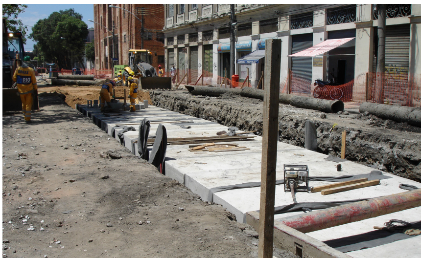
Figuras 15 e 16 – Escavação progressiva da galeria de águas pluviais e escoramento com blindagem metálica para implantação das aduelas de concreto ao longo da trincheira da galeria de águas pluviais – Frente 1.
