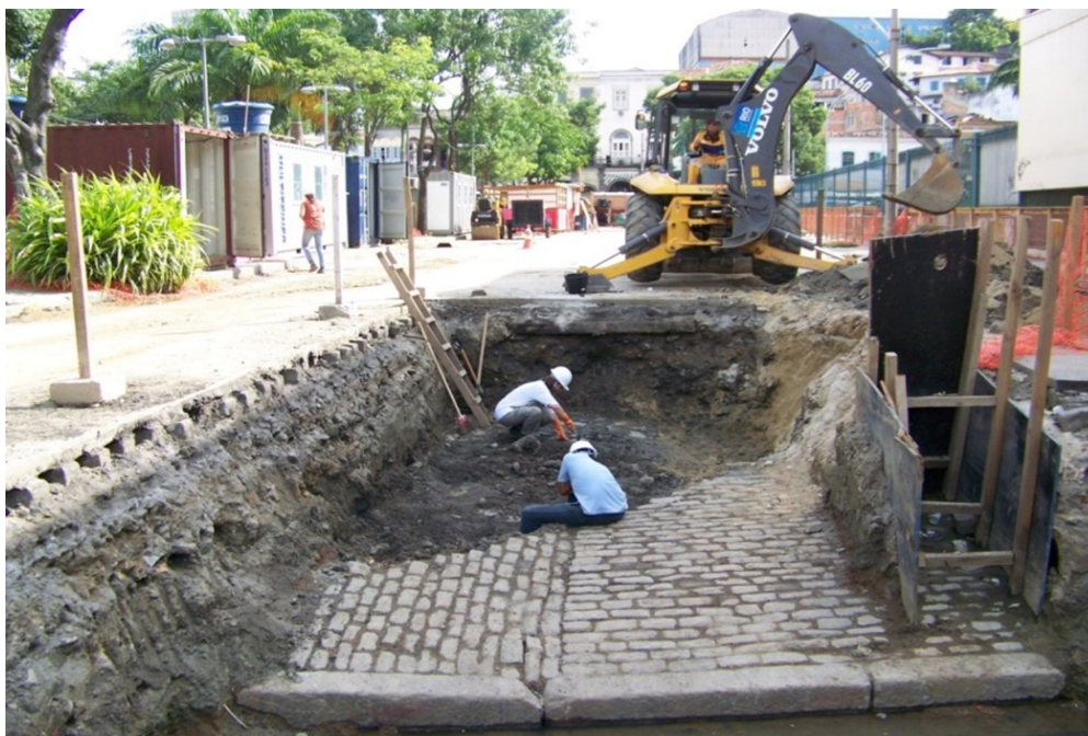
Figura 20 – O corte em diagonal feito nos paralelos, no passado, que permitiu o aprofundamento da escavação e o achado do calçamento do Cais do Valongo.
