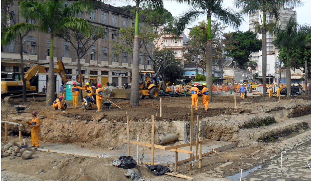
Figura 108 – Nivelamento do piso da praça.
