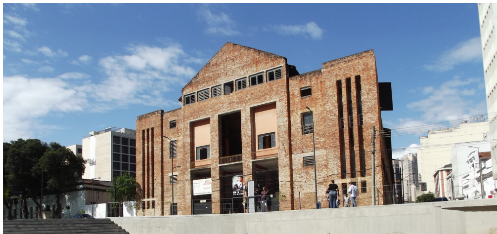
Figura 49 – O edifício das Docas D. Pedro II, ao lado do Cais da Imperatriz.
