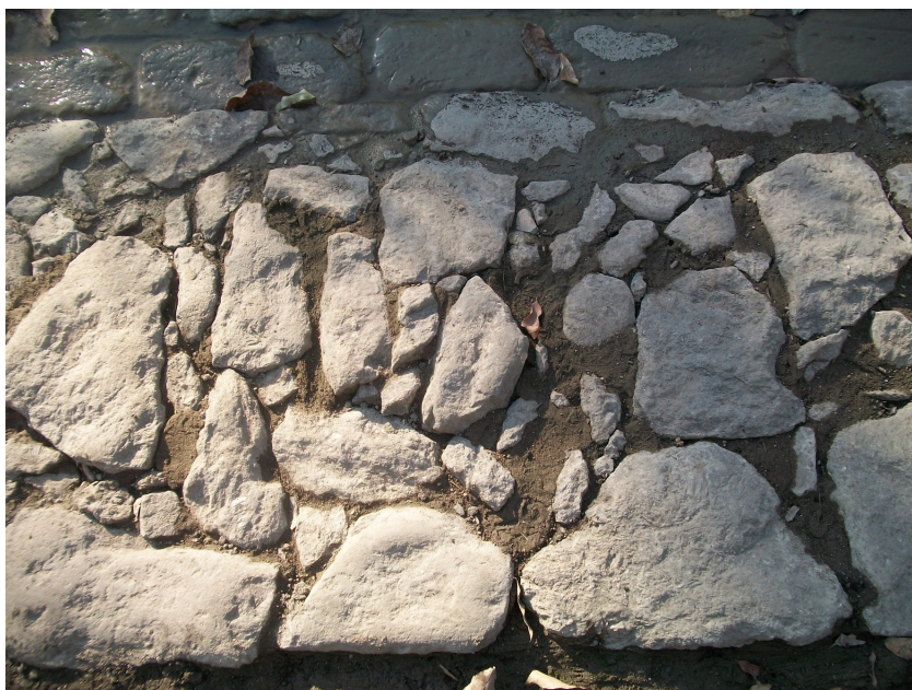
Figuras 99 e 100 – A execução esmerada do calçamento do Cais do Valongo.
