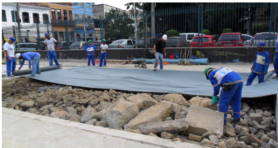
Figura 111 – Área de armazenamento provisório das pedras retiradas do Cais do Valongo e do Cais da Imperatriz, aguardando o trabalho de recomposição do seu calçamento, e recobrimento do depósito provisório com o geotêxtil bidim para fins de proteção.
