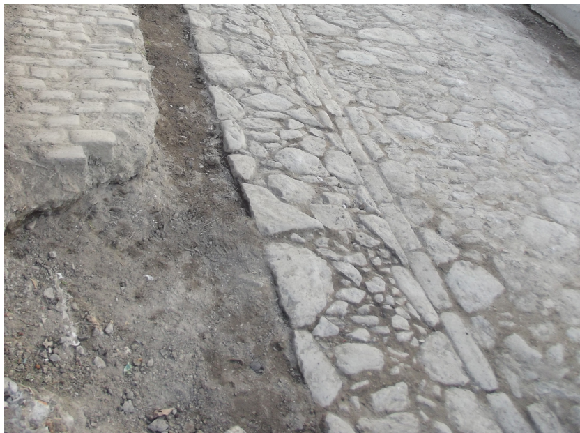
Figura 101 – A execução esmerada do calçamento do Cais do Valongo.
