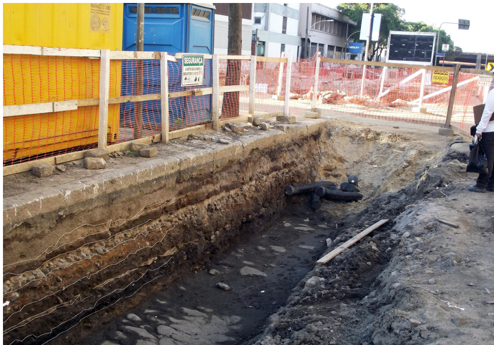
Figura 63 – O calçamento do Cais do Valongo aparecendo bem preservado na trincheira paralela da Frente 1, a 1,60 m de profundidade, na altura dos Trechos 7 e 8.
