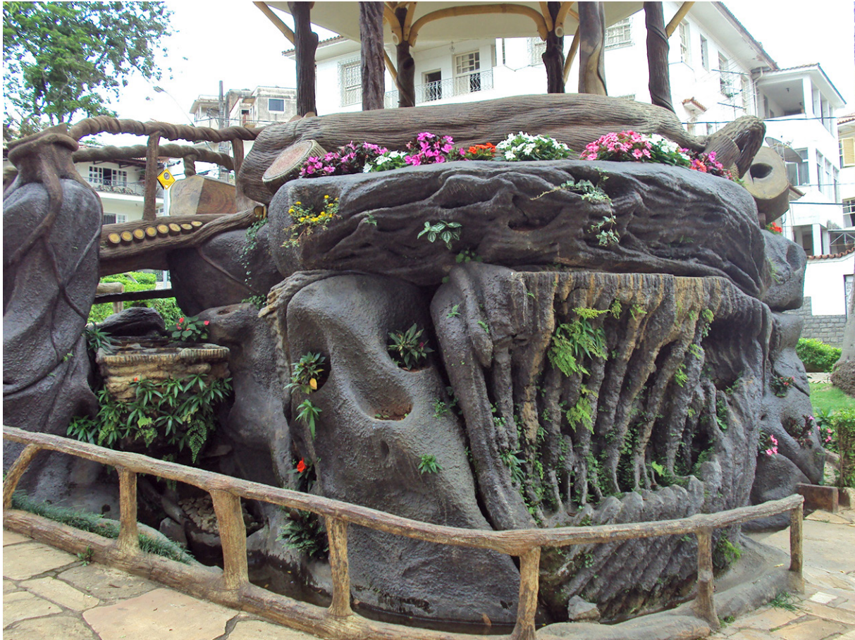
Figura 21 – Detalhe do coreto original de Francisco da Silva Reis após receber camadas de pintura, durante reconstrução das obras do cascateiro, em 2011. Praça de Carmo de Minas. Fotografia de Cristiane Magalhães, 2011.
