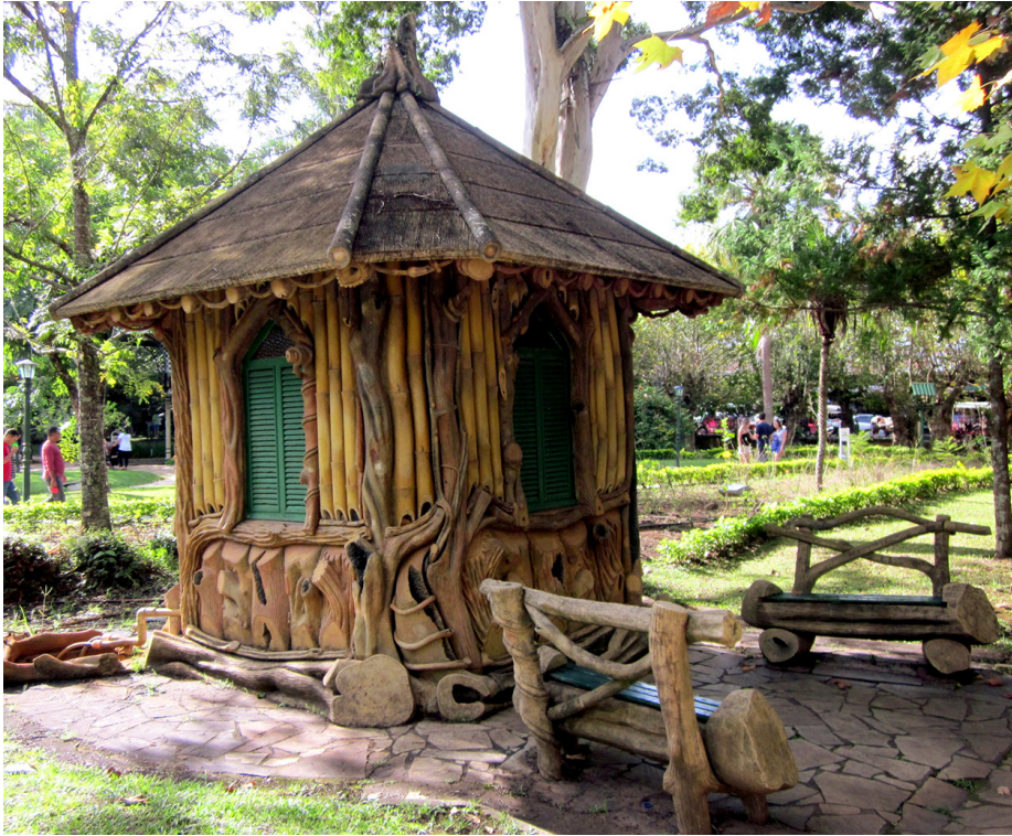
Figura 14 – Casa de máquinas e bancos modelados em cimento armado por Francisco da Silva Reis no Parque das Águas de Caxambu. Fotografia de Cristiane Magalhães, 2014.
