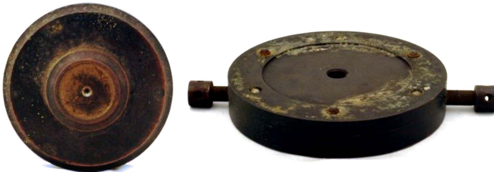
Figuras 7a, 7b e 7c – Corrosão ativa com produtos de salinização e esfoliação. Fotos: Ricardo Dias, 2013.
