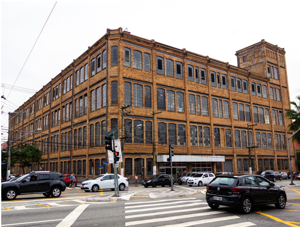
Figura 4 – Fachada lateral do edifício do antigo Cotonifício Crespi, maio de 2019. Fotografia: Carolina Figueiredo Lourenção.
