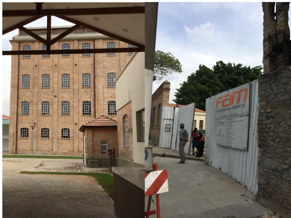
Figuras 2 e 3 – Um dos moinhos Minetti e Gamba e entrada do canteiro de obras da Faculdade das Américas, instituição de ensino que funcionará nas antigas instalações do Moinho, maio 2019. Fotografia: Clarissa M. R. Gagliardi
