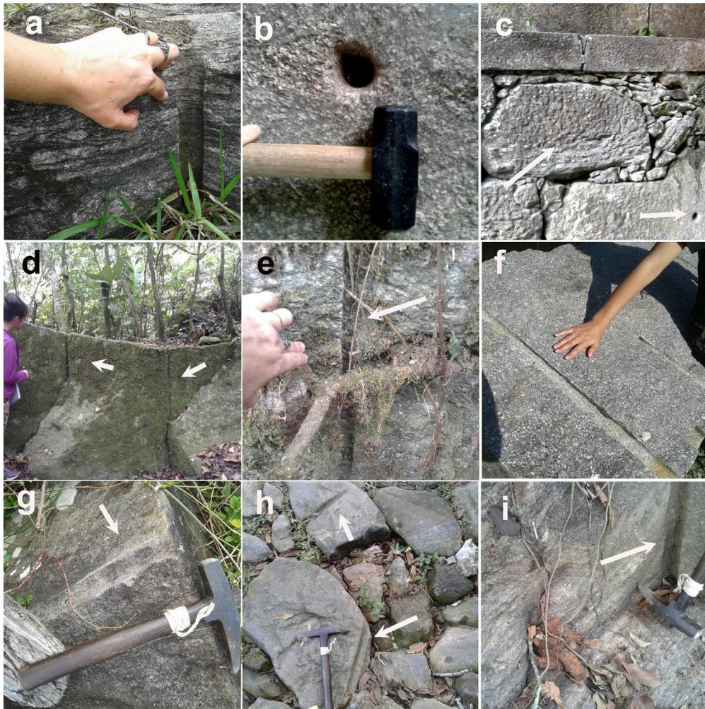
Figura 9 – Marcas de extração. Estrada de Mangaratiba: gnaisse (a), granito (b); picotes e perfuração em pedras secas (c); jazida na subseção 1 (d); cantaria da Ponte Bela (f). Estrada do Atalho: rocha da planície (g); pavimento (h); segmento da serra (i), Foto: Soraya Almeida, 2018.
