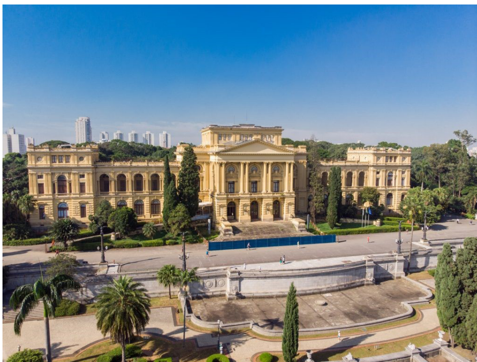
Figura 9 – A fachada no museu antes da realização das obras que preveem o acesso de entrada não mais pelas escadarias, mas pelas aberturas realizadas na esplanada, como se viu na Figura 8. Disponível em: https://bit.ly/3O3970i . Acesso em: 27 jan. 2022.
