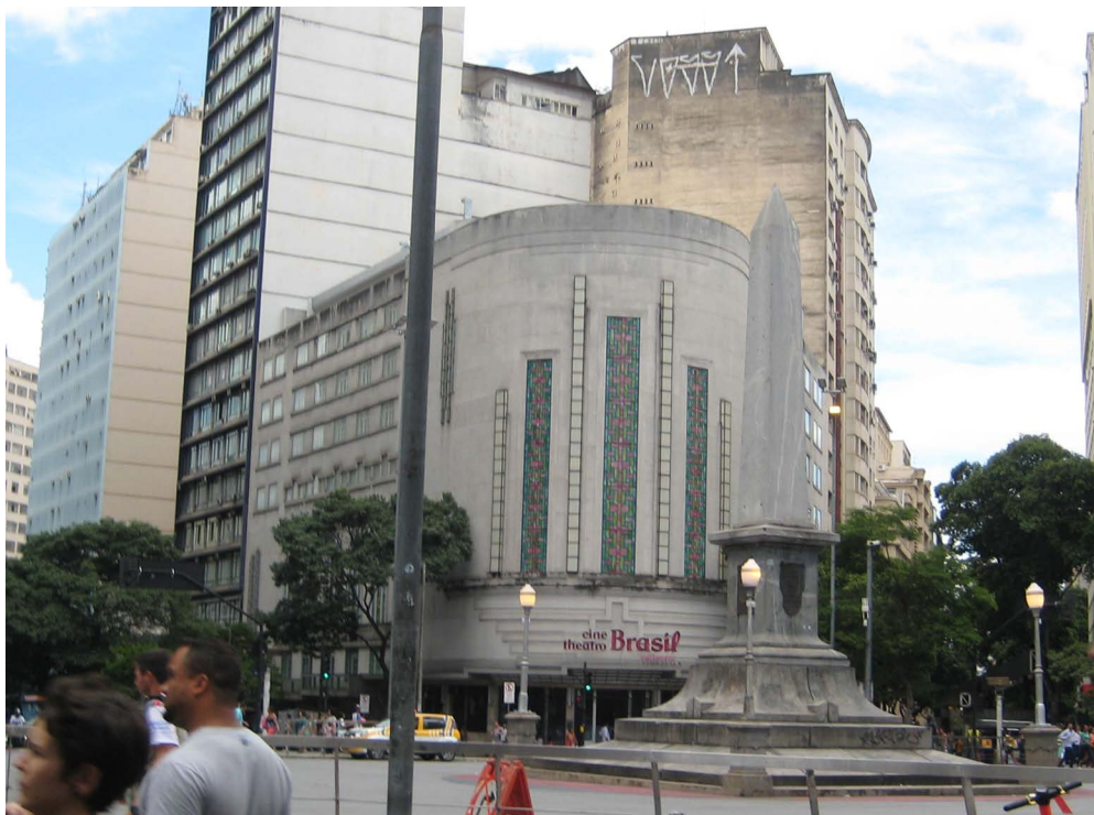
Figura 1 – Vista do Cine Brasil (1932), art déco , com românticos estilísticos modernos, incluindo arcos construtivos, com os seus oito pavimentos com estrutura em concreto armado, 2019. Foto: autor.
