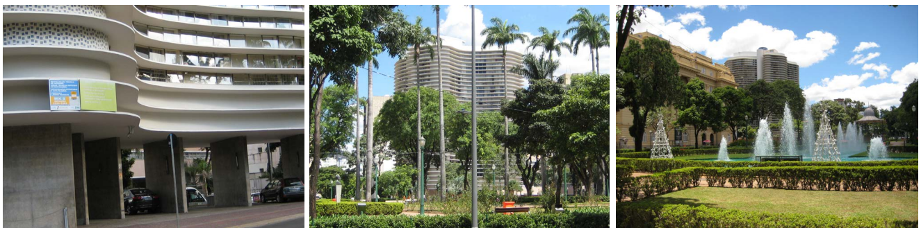
Figuras 4a, 4b e 4c – Vistas do edifício de apartamentos Niemeyer: (a) no contexto da praça da liberdade; (b) vista frontal do edifício – ondulações que lembram o COPAN – SP; e (c) detalhe do piso térreo – livre, com o uso de pilotis, 2019. Fotos: autor.
