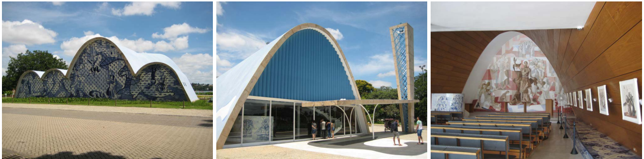
Figuras 3a, 3b e 3c – Vistas da capela de São Francisco de Assis, após recentes trabalhos de preservação. Da esquerda para a direita: acesso principal incluindo os brise-soleils superiores e a torre do sino; fachada posterior com azulejaria de Portinari e vista interior, 2019. Fotos: autor.
