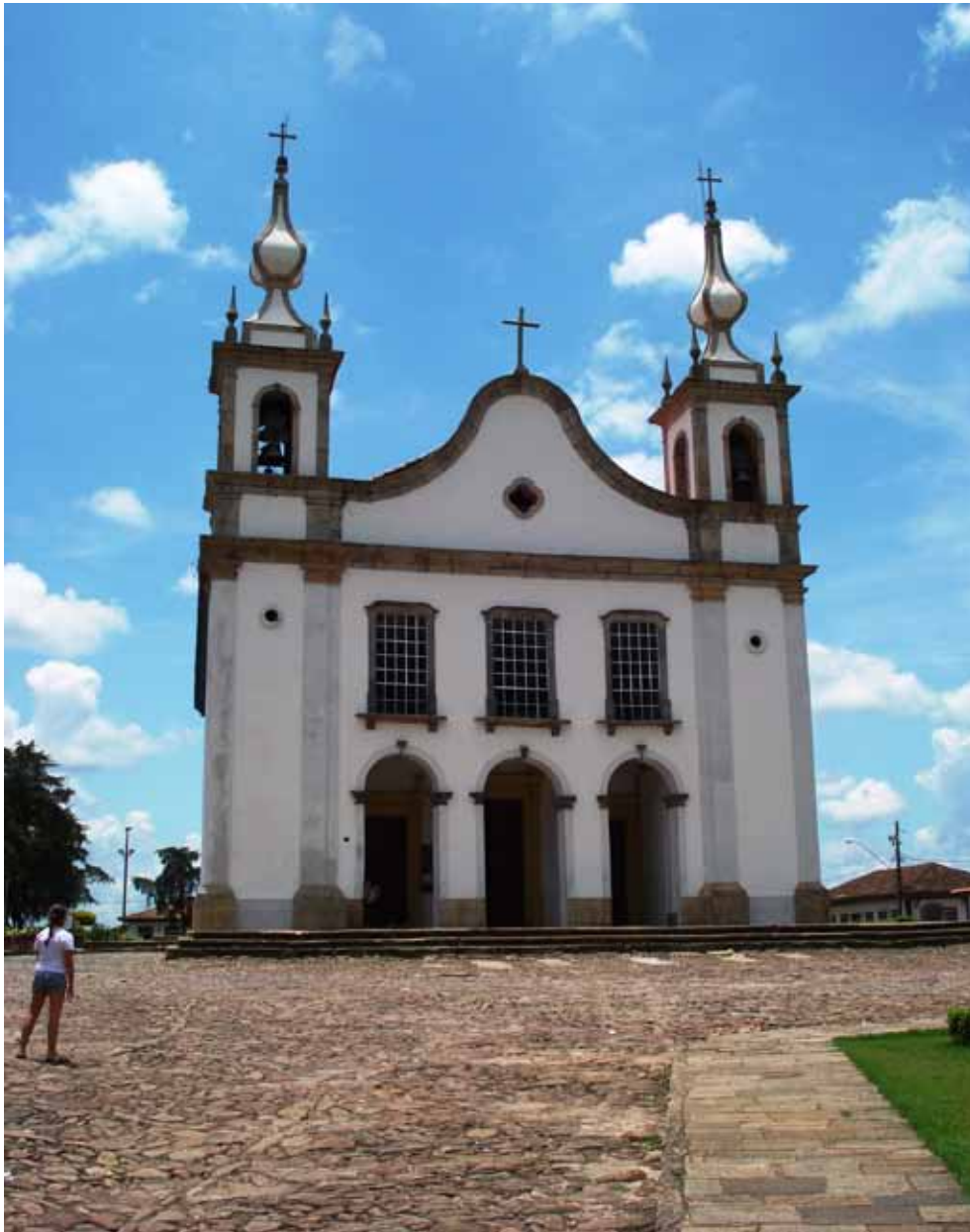
Figura 7: Praça da Matriz de Nossa Senhora da Conceição, Catas Altas, abril de 2002. Fotografia e acervo do autor.
