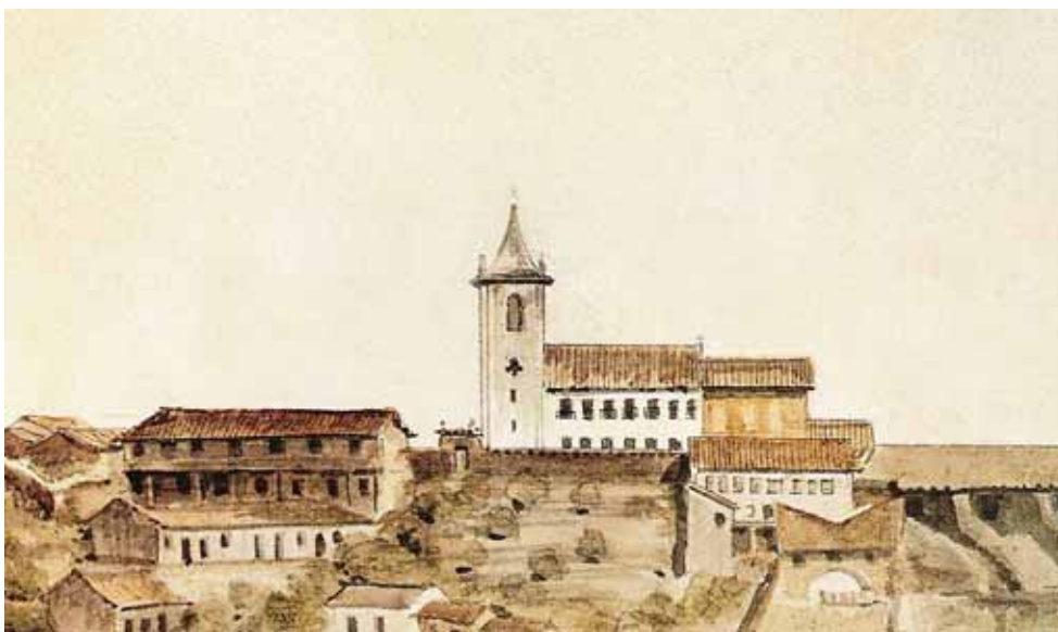
Figura 7 – A cidade de São Paulo vista da várzea do Carmo – parte Norte. Arnaud Julien Pallière, 1821. Coleção Beatriz e Mário Pimenta Camargo. Observar, à esquerda e à direita do portão de acesso à várzea, os fundos das casas de aluguel dos beneditinos, projetadas em 1787.
