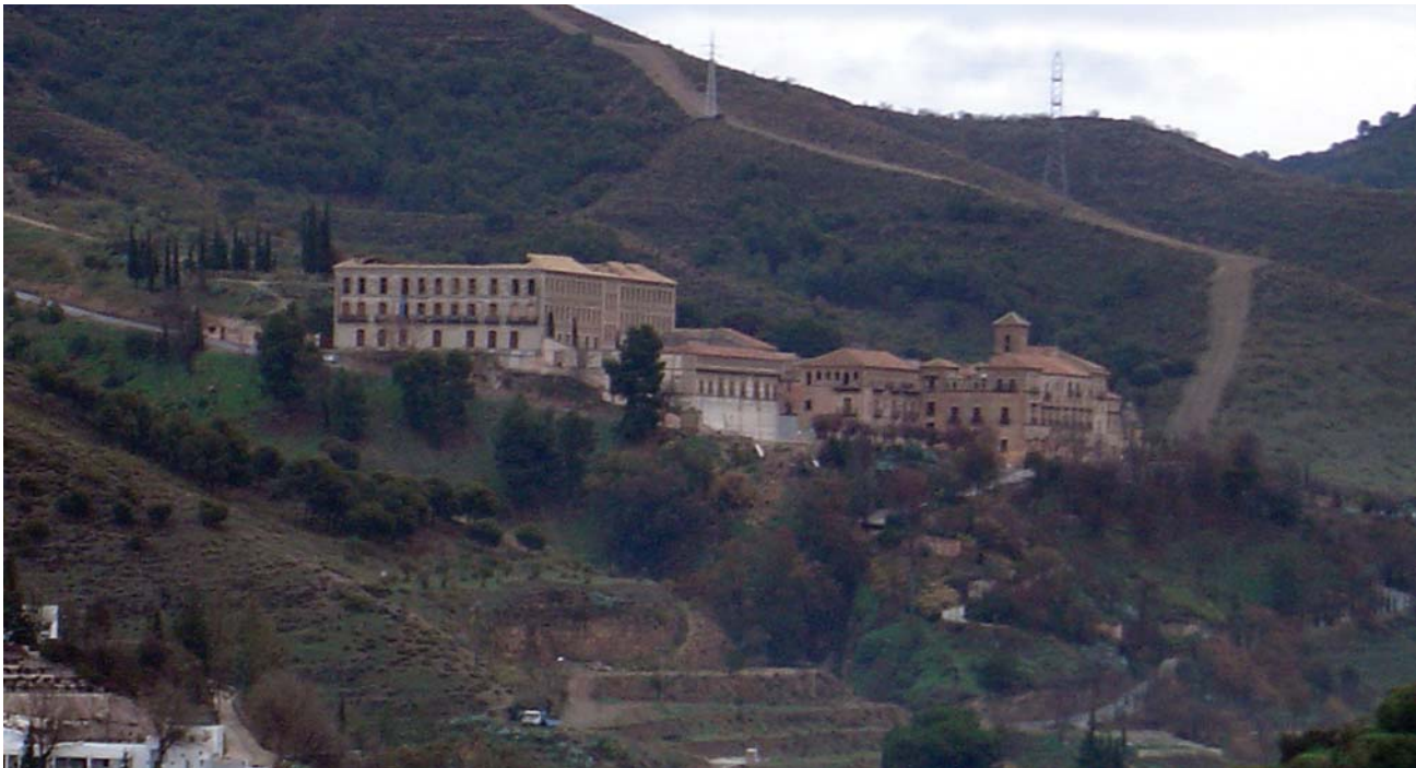
Figura 1 – Abadia beneditina do Sacromonte, edificada no local onde foram descobertas, no final do século XVI, as relíquias de são Cecílio, primeiro bispo de Granada e discípulo de são Tiago, e de outros mártires do século I. A Abadia do Sacromonte foi um importante centro de educação e imprensa no século XVII. Fotografia do autor, 2006.
