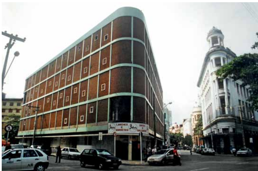
Figura 2 – Edifício Luciano Costa com a fachada de cobogós. Fotografia de 2001. Parecer de José Aguilera. Acervo 5º SR – Iphan / MinC, Recife.
