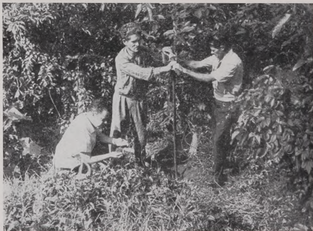
Foto 4 — Fase de trabalho de perfuração a trado.
