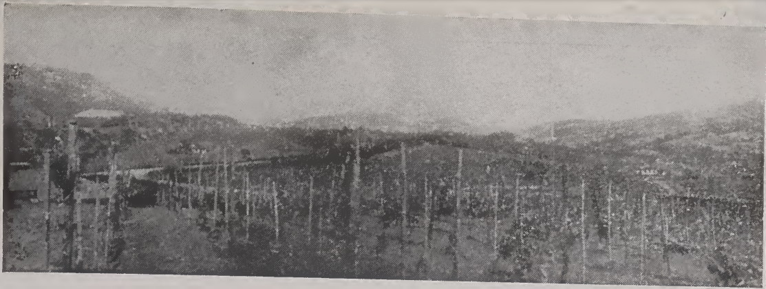
FOTOGRAFIA 1 — Vista do vale do ribeirão dos Marmeleiros (sentido oeste). À esquerda uma elevação granítica cuja base marca o contacto com a faixa calcária ocupando toda a zona restante, inclusive a encosta do morro dos Marmeleiros, que se vê à direita.
