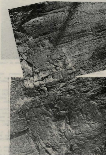
Figura 3 - Vista geral do pavimento estriado.
