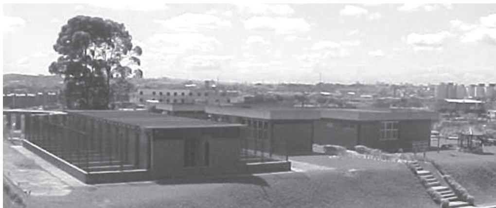
Figura 1 - Vista da Seção de Cães-de-Guerra do 2º BPE, tendo o pavilhão de canis individuais à esquerda
