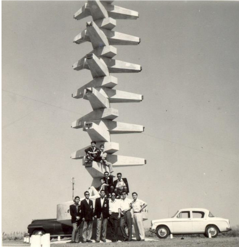
Figura 10: Torre da fábrica de cimento (Matola). Fonte: cortesia das famílias Kwan Vei Quio e Humano Fon Switta (Local: município da Matola, circa 1950).
