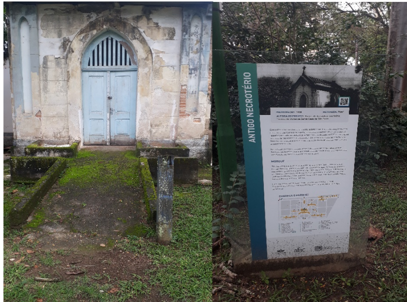
Figura 8- O necrotério aguarda restauro
