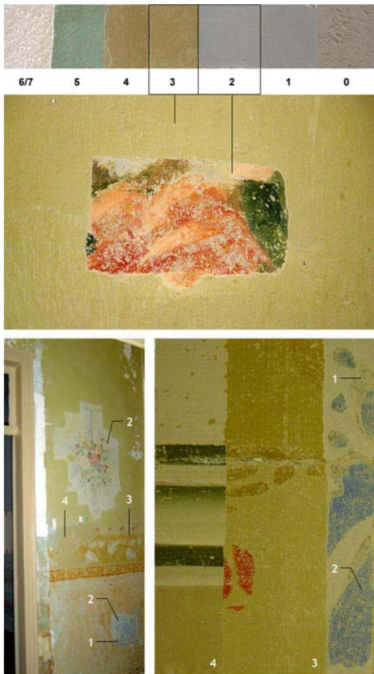
FIGURA 03 – (1) Faixa estratigráfica: Quantifica o número de camadas de tinta e/ou materiais sobrepostos nas superfícies murárias. (2) Área de decapagem. Mostra trecho de duas camadas da faixa estratigráfica (camadas 2 e 3). (3) Vista de parede durante decapagem. (4) Modelos de pinturas artísticas sobrepostas. Ornatos e cores de quatro camadas de pintura executadas em épocas diversas em um mesmo cômodo. O Corredor 1. Fonte: Arquivo CPC-USP. 2004.
