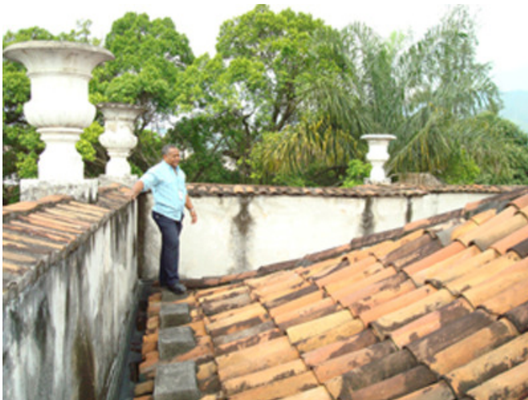
FIGURA 05 - Telhado do Museu do Primeiro Reinado. Fonte: Fotografia de Marisa Hoirisch.
