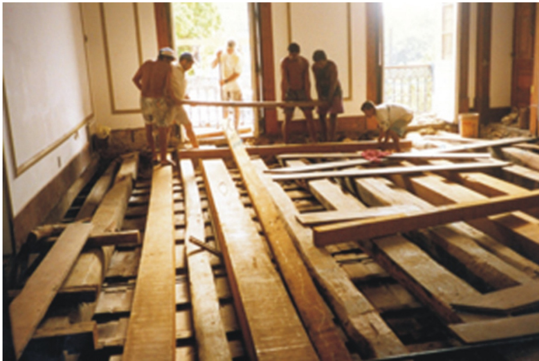
FIGURA 09 - Restauração do piso do Palácio Universitário. Fotografia de Marisa Hoirisch, 1996.
