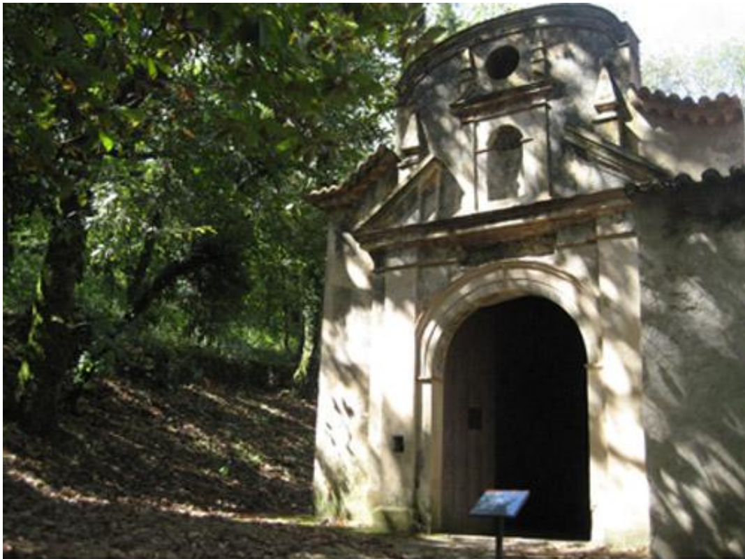
Figura 05 - Edifício dos silos de armazenamento com sinalização exterior. Fotografia: Karina Souza
