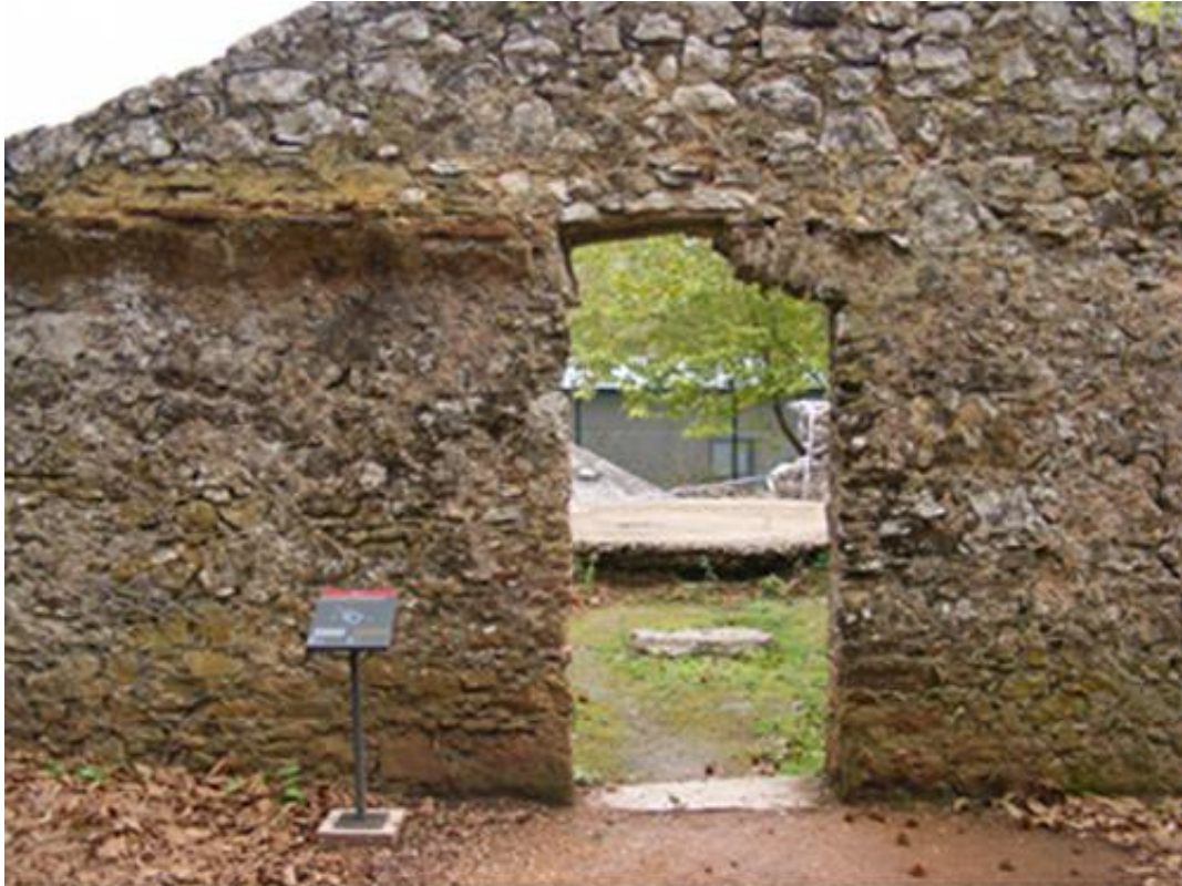
Figura 04 – Vista das ruínas da casa da nora e tanques de captação de água. Fotografia: Karina Souza
