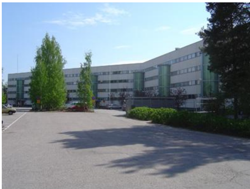
FIGURA 16 - Lauri Silvenoinen, Pihlajamäki, 1963-64, blocos com caixas-de-escada adicionadas. Fotografia: Fernando Diniz Moreira.
