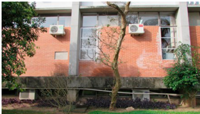
FIGURA 12 Alteração da fachada com inclusão de janelas verticais no térreo. Fotografia das autoras.
