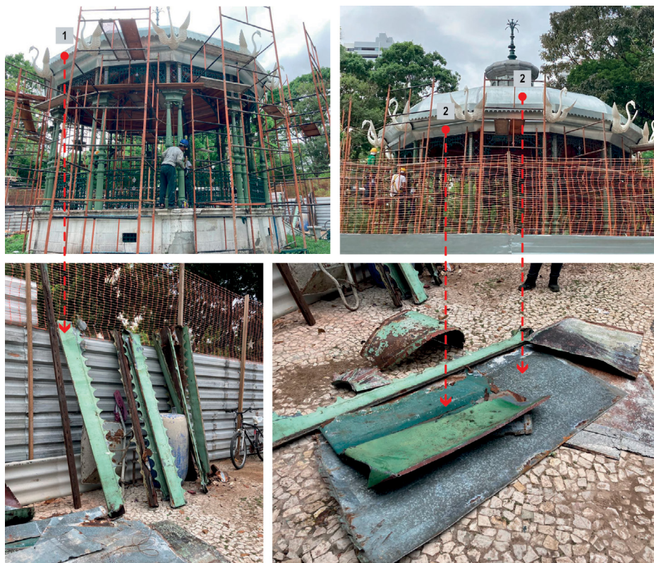
1- Lambrequins; 2- Lâminas de cobertura.
