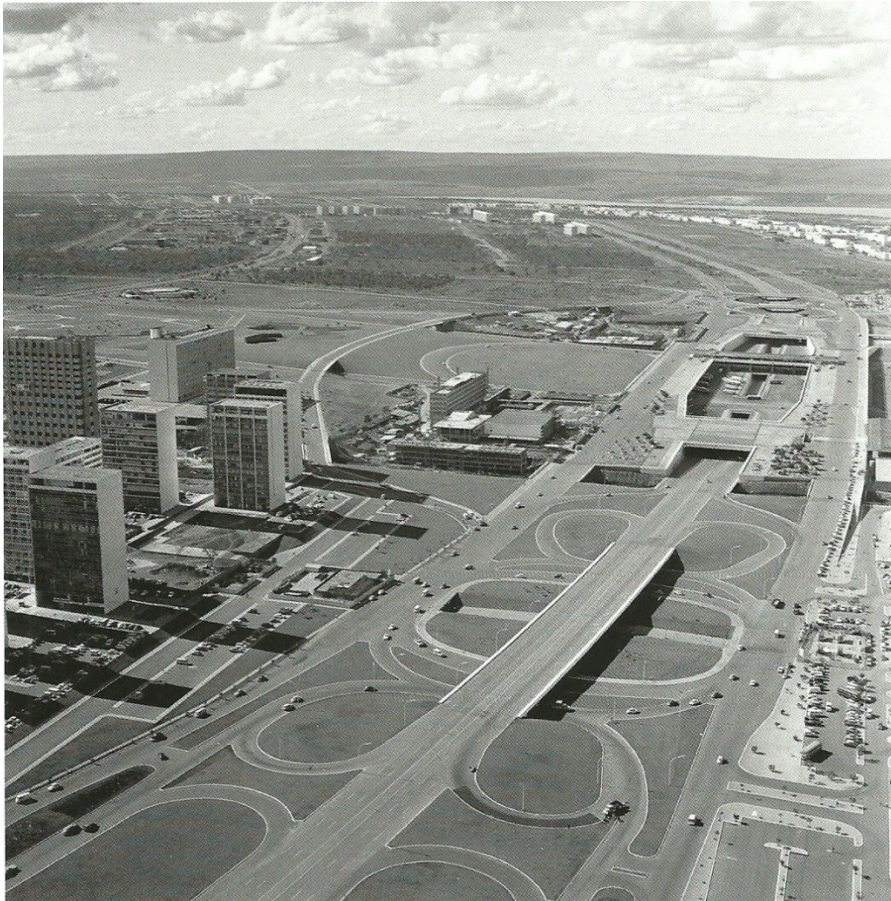
Figura 3 – Setor Comercial Sul (à esquerda), Setor de Diversões (no centro da fotografia) e Plataforma Rodoviária do Plano Piloto (à direita). Fonte: Acervo ArPDF. Fotografia: Mário Fontenelle.
