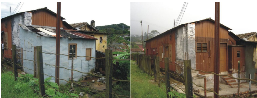
FIGURAS 8 e 9. Remoção de anexos irregulares e precários.
