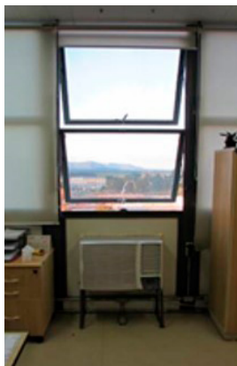
FIGURA 14 Módulo que compõe a fachada leste visto do lado interior e exterior. Fotografia das autoras.
