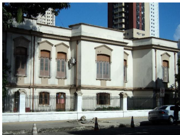
FIGURA 8 Fachada do pavilhão da Infância Bartholomeu Menezes - Hospital da Criança. Fonte: Karina Pamplona, 2013.
