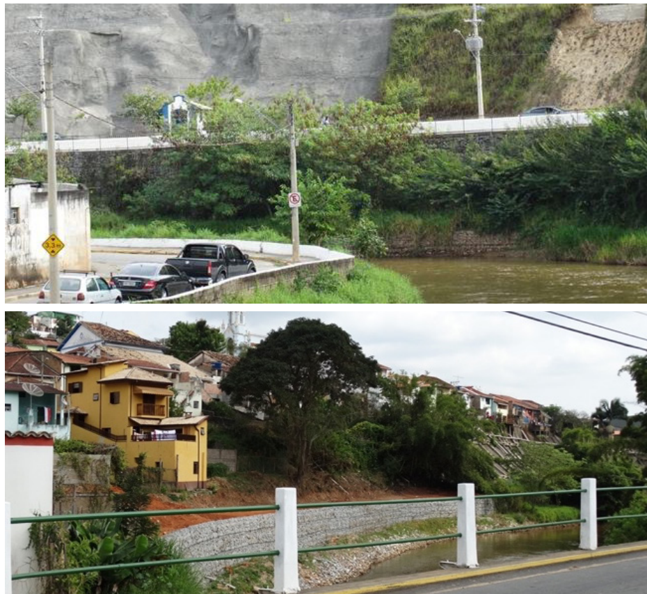
FIGURA 3 e 4 Soluções técnicas convencionais de contenção das encostas do rio Paraitinga. Fotografia: Renata Allucci, 2020.
