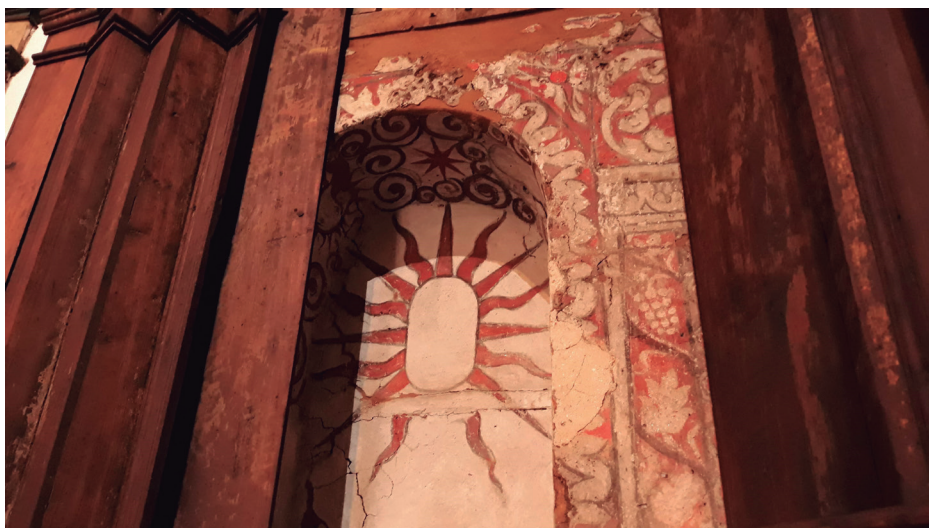
Figura 1 – Detalhe do camarim da pintura parietal do altar lateral do lado da epístola. Notar os desenhos de sol, lua, estrela e nuvens espirais no arco interno. Capela de São Miguel Arcanjo – São Miguel Paulista. São Paulo. Foto: Thais Montanari, abr. 2019.
