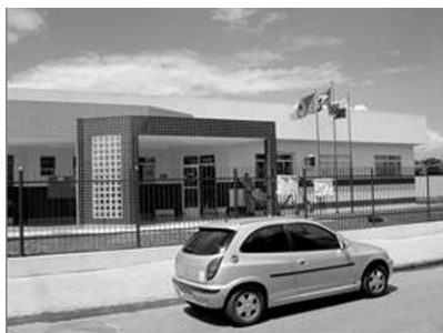
Figura 1 - Escola 1, vista da frente.
