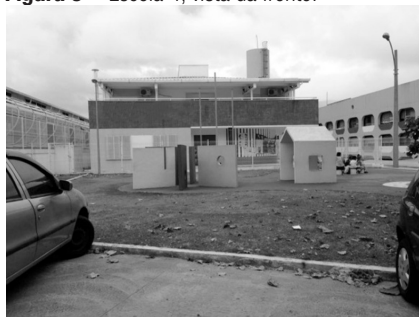
Figura 9 - Escola 4, vista da frente.
