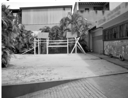
Figura 14 - Escola 6, vista do pátio.
