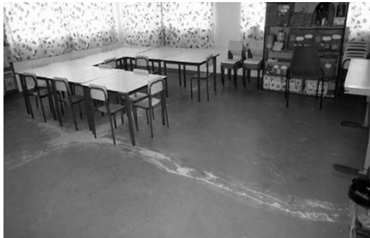
Figura 26- Reparo das rachaduras no chão na escola 7.
