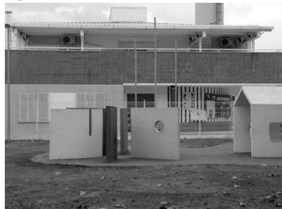
Figura 29 - Elementos de concreto fixos na escola 4.
