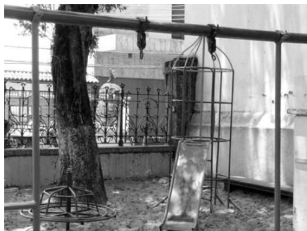
Figura 45 - Escorrega com a pintura desgastada na escola 3.
