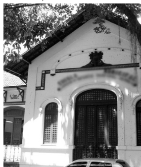
Figura 6 - Escola 3, vista da frente.
