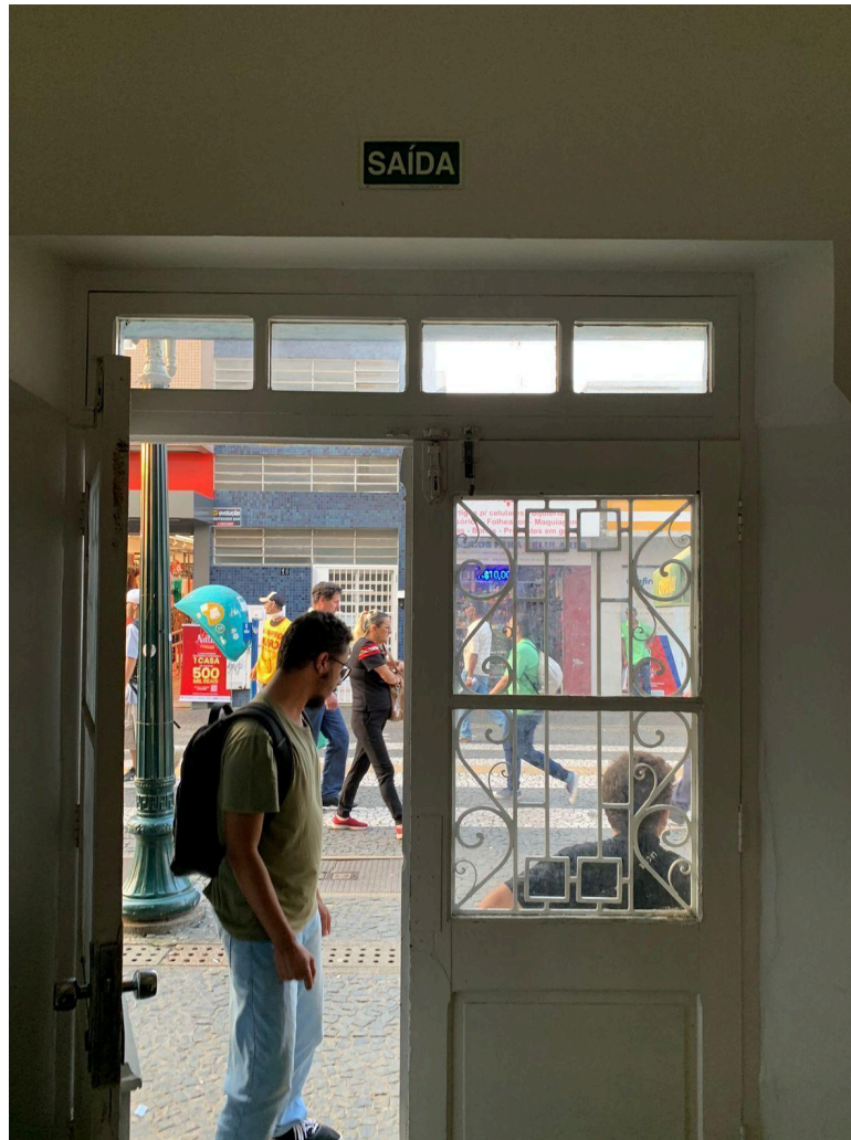
Figura 3: Porta do Edifício Manente. Fonte: (Jeferson de Souza, 2023).
