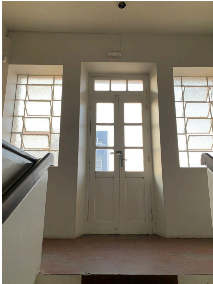
Figura 7: Porta de acesso à sacada lateral. Fonte: (Jeferson de Souza, 2023).
