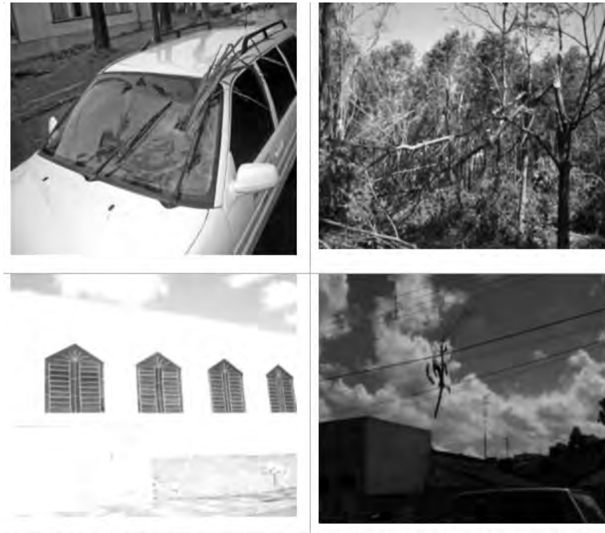
Figuras 3a a 3h – Danos provocados pelos tornados em Santa Bárbara d'Oeste (3a,3c,3d e 3f, 3g.e 3h) e Piracicaba (3b e 3d) (Fotos: equipe do LECLIG)
