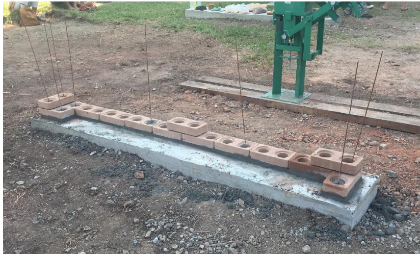
Figura 1. Montagem da primeira fiada de alvenaria de blocos de solo-cimento.
