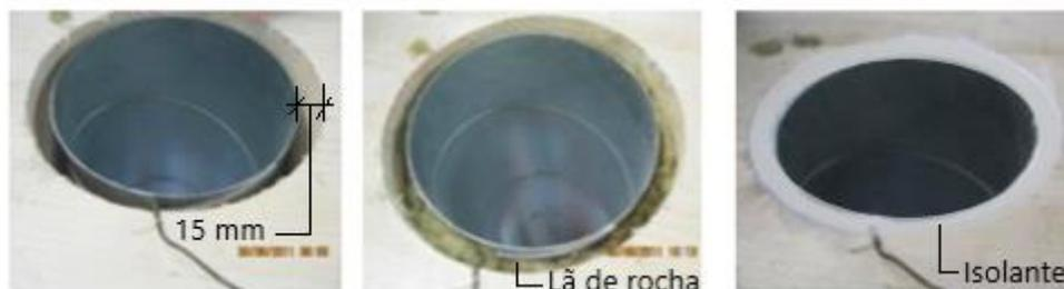
**Figura 5.** Etapas a seguir para a proteção da tubulação metálica no painel de CLT
