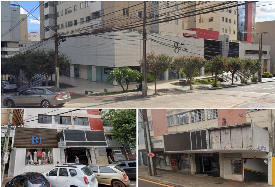
Figura 10. Fachadas das galerias 3B e 3C, respectivamente.
