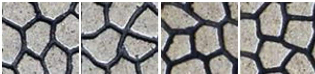
Figura 4. Preenchimentos irregulares contidos nos ladrilhos.
