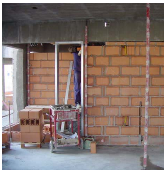
Foto 2: Colocação dos batentes metálicos junto com a elevação da vedação
