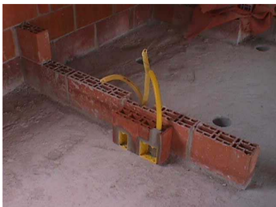
Foto 8: Detalhe da locação da vedação
