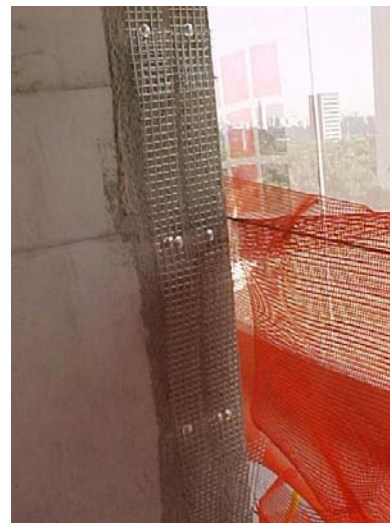
Foto 4: Detalhe da ligação estrutura-parede
