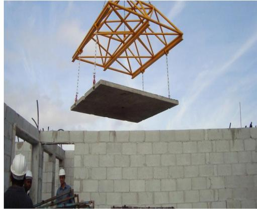
**Figura 7.** Laje sendo posicionada horizontalmente.
