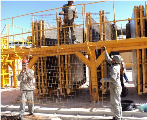
**Figura 6.** Lajes concretadas na vertical.
