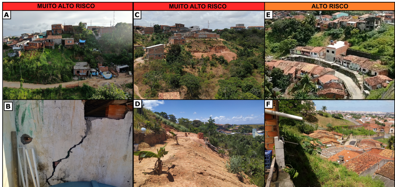
Figura 14. Visão geral dos principais setores de risco mapeados no Bairro Cidade Nova. (A) Moradias no topo e na base de encosta natural e de corte com histórico de escorregamento e rastejo de solo. (B) Feições de instabilidade exemplificadas por rachaduras diagonais nas residências. (C) Talude de aterro e de corte na meia encosta. (D) Sulcos e rachaduras no talude de aterro indicando erosão superficial e movimentação de massa. (E) Talude natural com inclinações superiores a 40°. (F) Lançamento de água servida na encosta.
