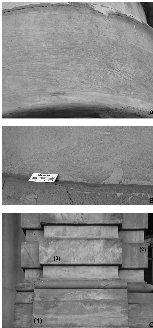
Figura 3. Estruturas sedimentares observadas na fachada do Teatro Municipal. A. Estratificação cavalgante. B. Estratificação sigmoidal. C. Diferentes posições da estratificação observada nas placas de revestimento: 1. estratificação em posição horizontal, 2. estratificação em posição vertical, 3. corte paralelo à estratificação (similar à vista em planta).
