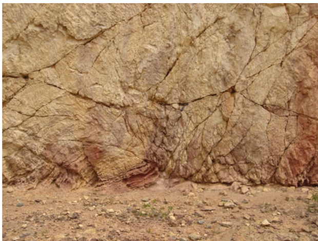
Figura 8. Continuidade para sudeste (duas dezenas de metros) do mesmo corte da Figura 7. Além do dobramento tipo flanco longo - flanco curto, verifica-se a intensa deformação rúptil superposta (cisalhamento em leques imbricados), com indicadores cinemáticos de NNW para SSE (para o sentido do lado direito da foto). Numa linha vertical, a dimensão do afloramento é de 2 m.
