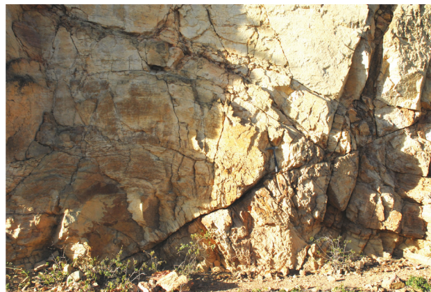
Figura 7. Quartzitos e metapelitos da Formação Morro do Chapéu, Serra de Rodoleiros, em corte na rodovia BR-324. Dobramento tipo flanco longo (predominante na foto) — flanco curto (à direita do martelo). Indicação horária (de NNW para SSE) da cinemática, como na Figura 6.
