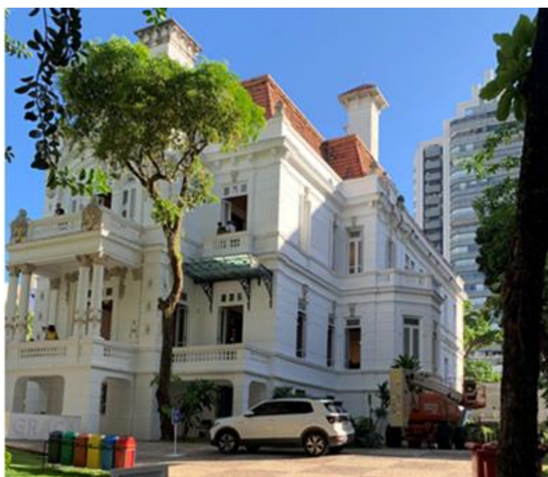
Figura 15 – Rossi Baptista. Palacete Martins Catharino. Veduta del fronte dell'edificio
