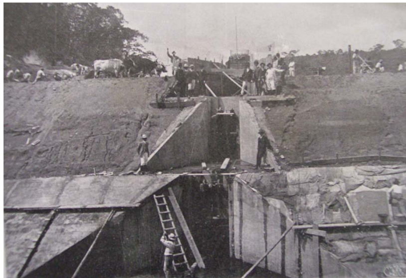
Figura 05 - Construção da Barragem do Engordador – Relatório da Secretaria da Agricultura – 1906
