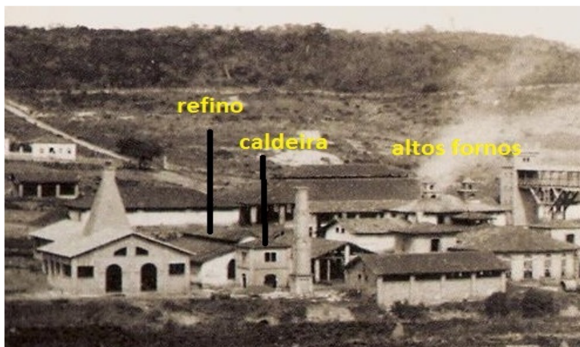
Figura 2 Detalhe de fotografia da Fábrica, feita por Julio Durski. Comparando com a planta ao lado, o prédio da cementação está muito maior na foto. Data da foto geralmente citada é 1885.
